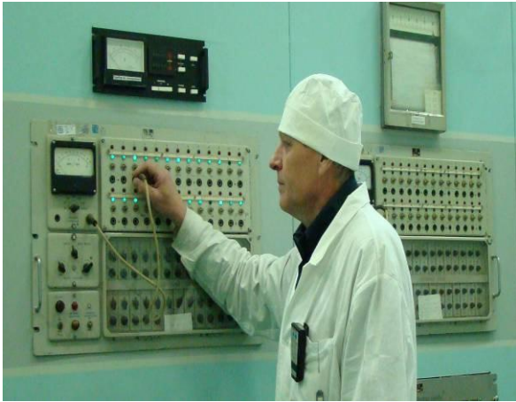
Центральный дозиметрический пульт системы радиационного контроля
