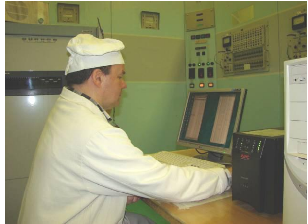
Центральный дозиметрический пульт системы радиационного контроля
