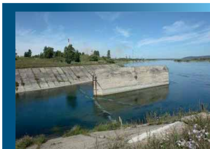
Водозабор АО «АЭХК»
