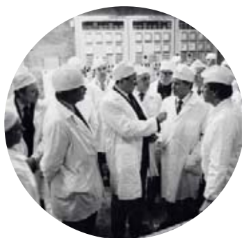
Секретарь ЦК В.И. Долгих перед пуском энергоблока №1, 1982 г.
