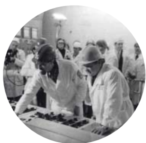
Включение в сеть энергоблока №3, 1980 г.
