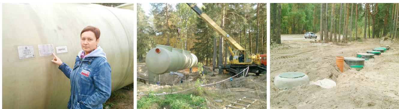
Установка очистных сооружений на выпуске № 2
