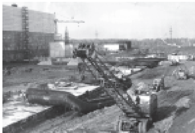
Фото 1. Монтаж трубопроводов водозаборных сооружений
