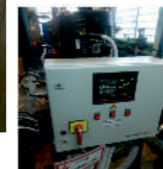
Система автоматического регулирования напора хозяйственно-питьевой воды
