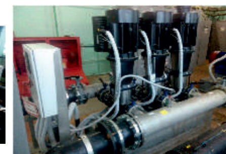
Система автоматического регулирования напора хозяйственно-питьевой воды
