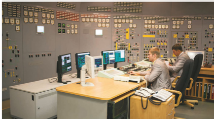
Блочный щит управления энергоблоком Балаковской АЭС
