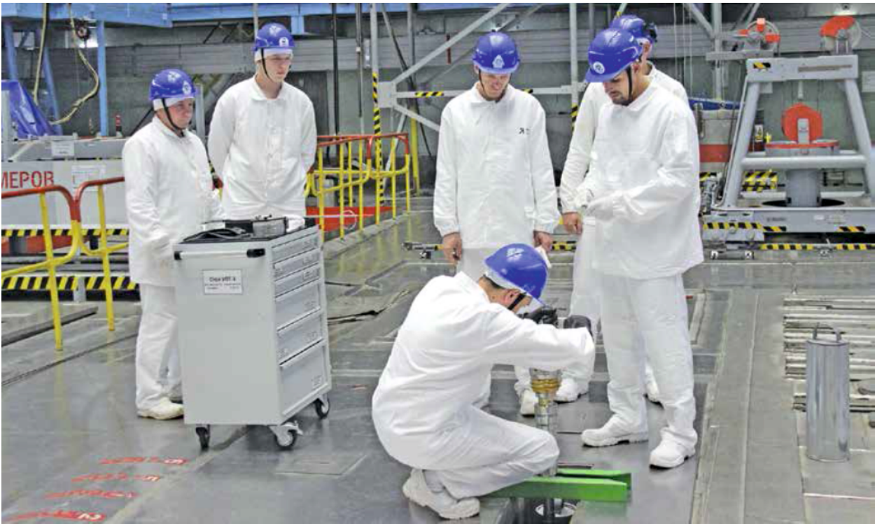
Фото 3. Подготовка к загрузке дополнительных кобальтовых поглотителей в реактор
