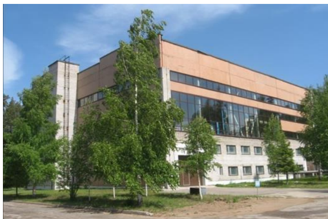
Производственное здание Ленинградского отделения филиала «Северо-Западный территориальный округ» ФГУП «РАДОН»
