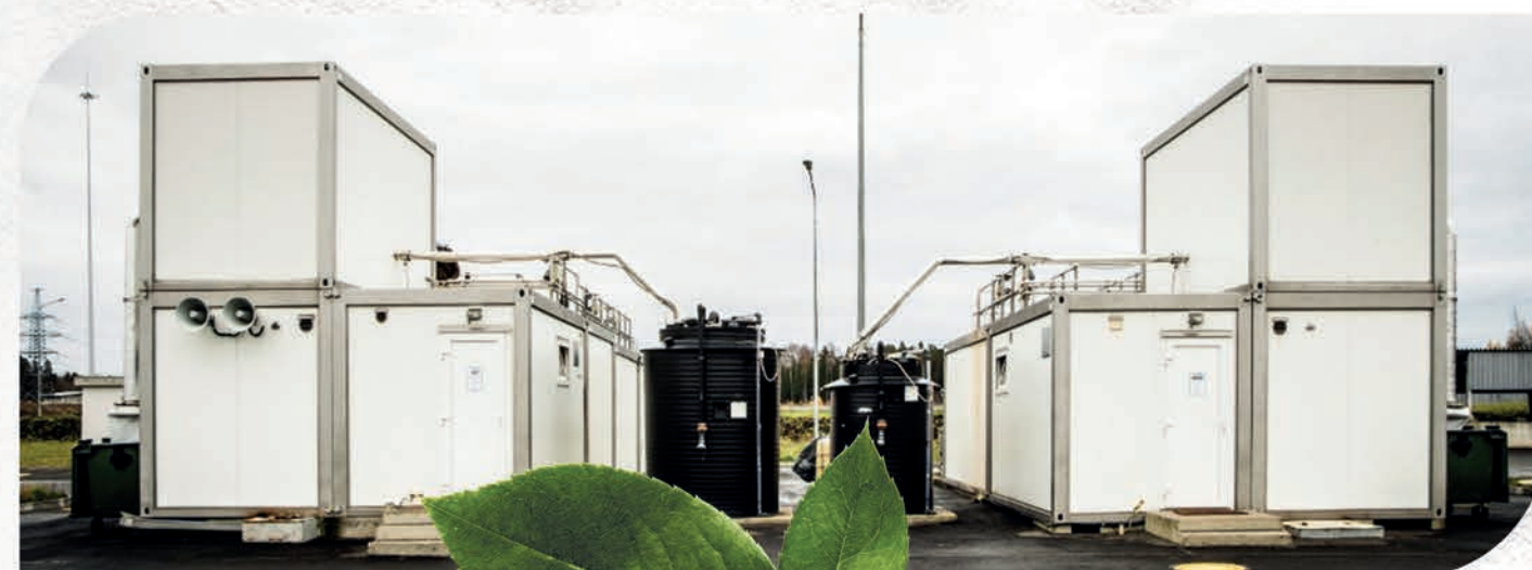
Очистные сооружения на площадке Ленинградской АЭС-2
